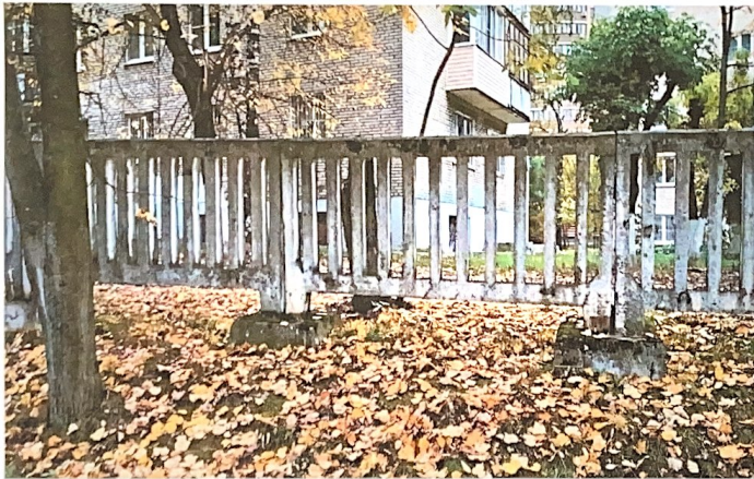
Замена ограждения МБОУ «СОШ №7»
